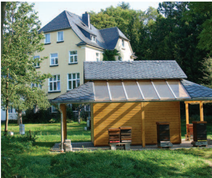
Das renovierte Hauptgebäude sowie im Vordergrund die im Jahr 2008 fertiggestellte, nach dem ehemaligen Leiter des Dienstleistungszentrums Westerwald-Osteifel benannte, Volker-Rudloff-Halle.
